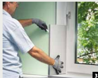
3 In beengten Verhältnissen eignen sich Vakuumsulationsplatten, um Raum zu erhalten.
