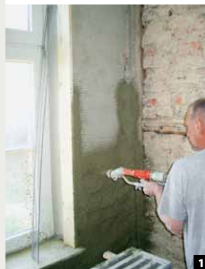
1 Dämmputzsysteme kommen häufig bei unebenen und schwierigen Untergründen zum Einsatz, beispielsweise im Denkmalschutz.
